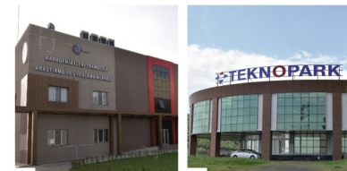
37 Kitam-Merkezi Laboratuvar Central Laboratory
