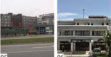
03 OMÜ Vakfı Koleji OMU Foundation School
